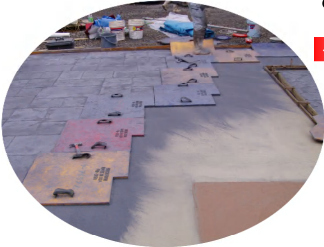
型を押してコンクリート表面に模様を写します
